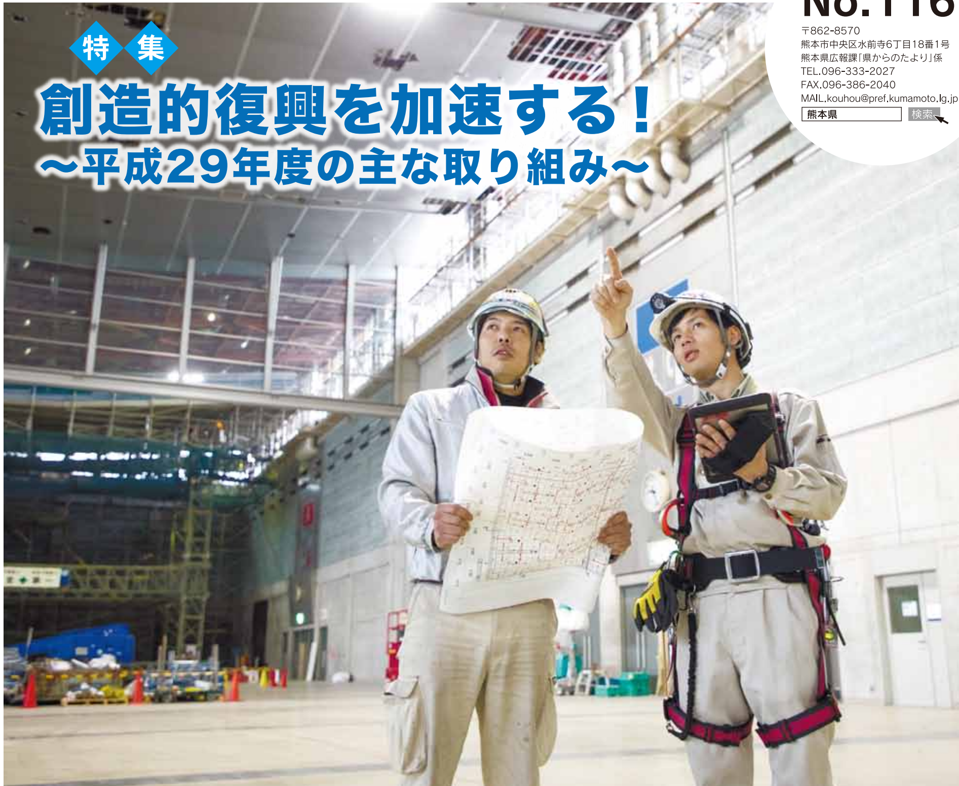
早期再開に向けて着々と進むグランメッセ熊本の復旧工事(撮影日 平成29年3月2日)
