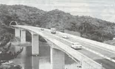
現在開通している松島有料道路
