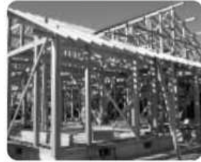
県産スギ柱材の提供を受けて新築中の住宅
