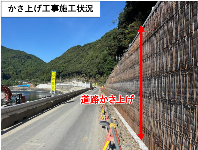
八幡橋周辺施工状況
