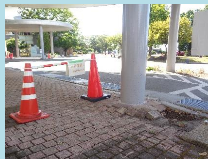
▲歩道ブロックの損壊、建物外周側溝の損壊
