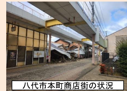
<被害状況写真>
