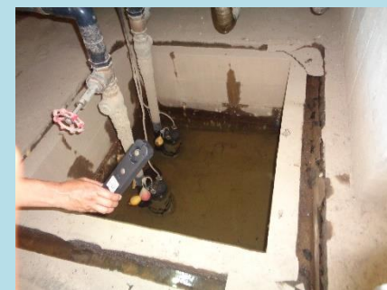
▲地下メンテナンススペースの漏水箇所
