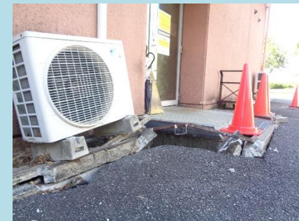
▲歩道ブロックの損壊、建物外周側溝の損壊
