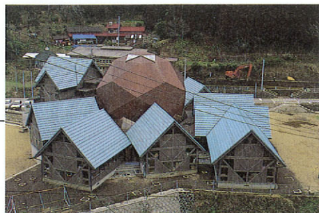
「西里小学校」 小国町が取り組んでいる「悠木の里づくり」の一環として建設された。木造トラス構造を駆使した中央のドームは多目的ホールとして文化活動や生涯教育の場としても使用されている。
