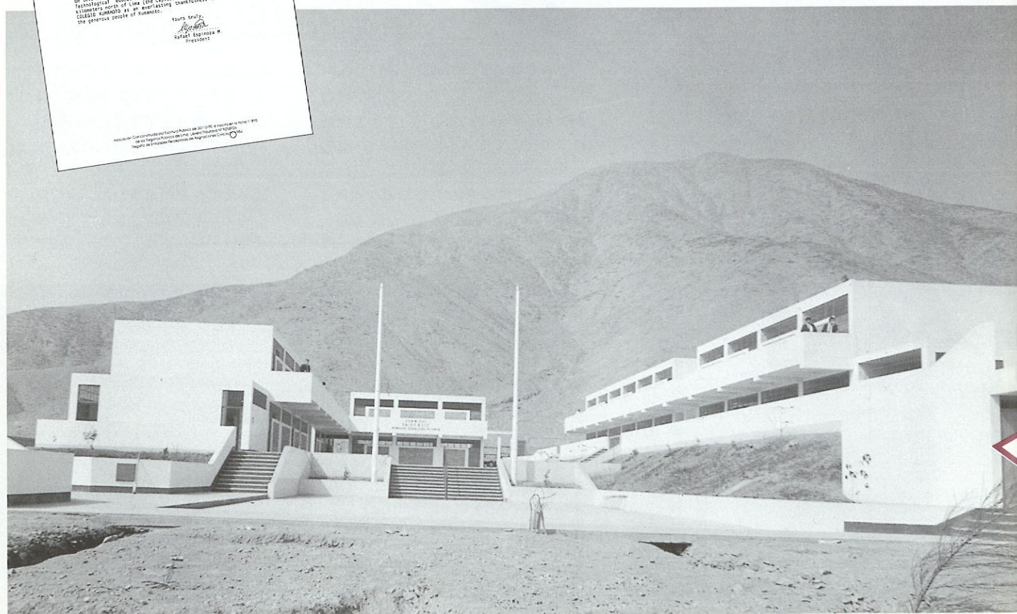
フジモリ・ペルー支援の会からの支援金で建設中の学校。建設中11校のうち1校には「くまもと学校」の名が付く予定。
