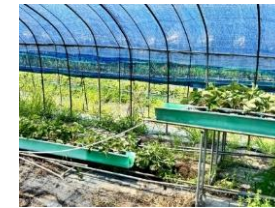
イチゴ高設育苗の破損（八代市）
