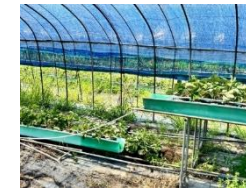
イチゴ高設育苗の破損(八代市)
