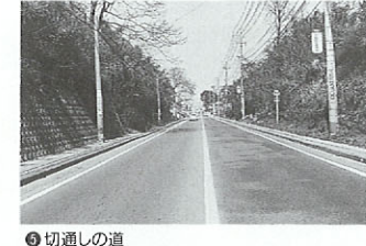
⑨切通しの道 加藤清正が軍事的配慮から作らせた四道。徳王（TKU周辺）から植木までの間、台地を二回（一八〇センチメートル）ほど掘り下げた所を道が通っている。戦の際、左右の崖上から下を通る敵を攻撃するために、また、自軍の動きを敵の目から遮断するために構築された。
