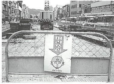
忠清南道庁〜大田駅通りの工事現場
