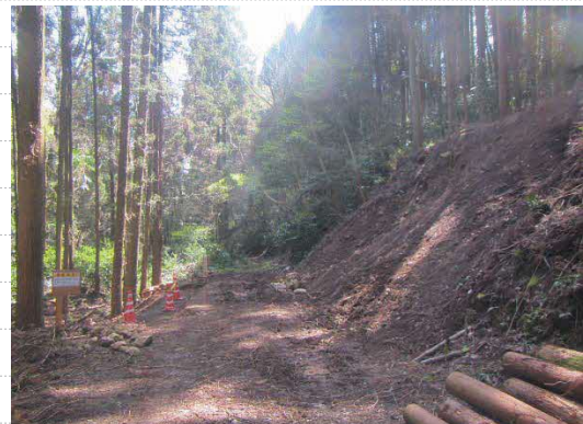
仮復旧作業後の状況
