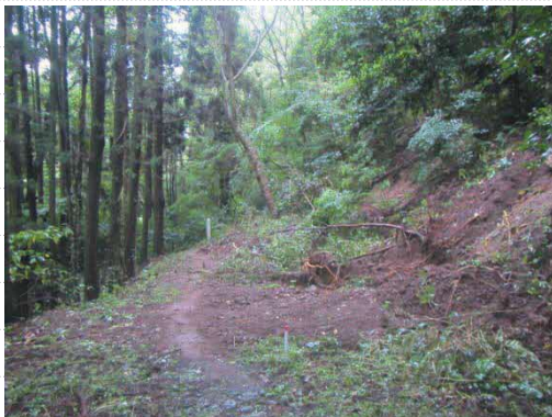
令和7年8月豪雨被害状況
