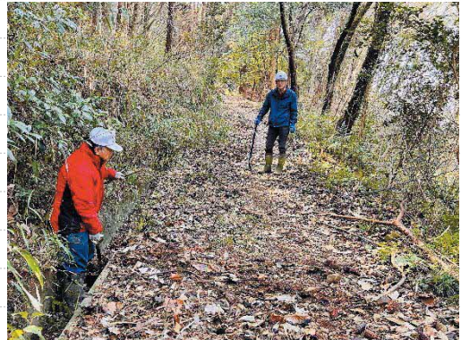
排水路整備作業状況
