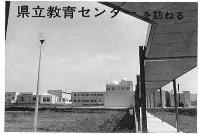
▲システム群をむすぶモダンな渡廊下
