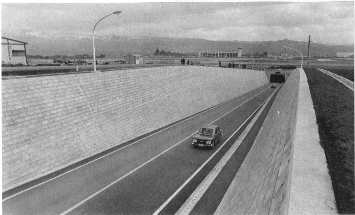
▲ 空港の地下連絡道も完成。この上に滑走路がある。後方に空港ビルが見える。
