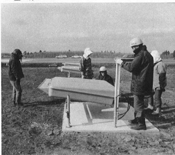
▼ 赤・青・黄の三色の光で、パイロットに進入指示を教える進入角指示灯の取り付けも終わり、最後の調整が行なわれている
