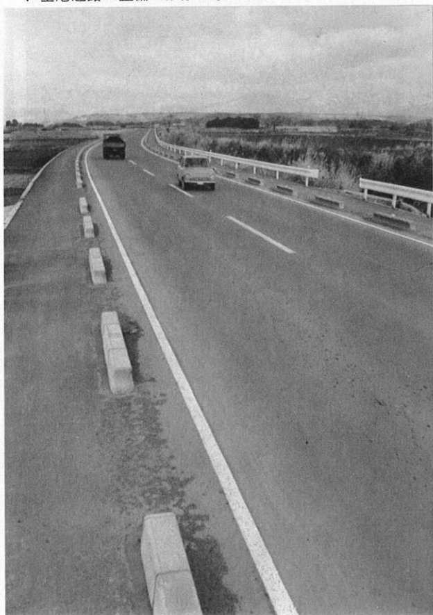
▼ 空港道路の整備もほぼでき上り。
