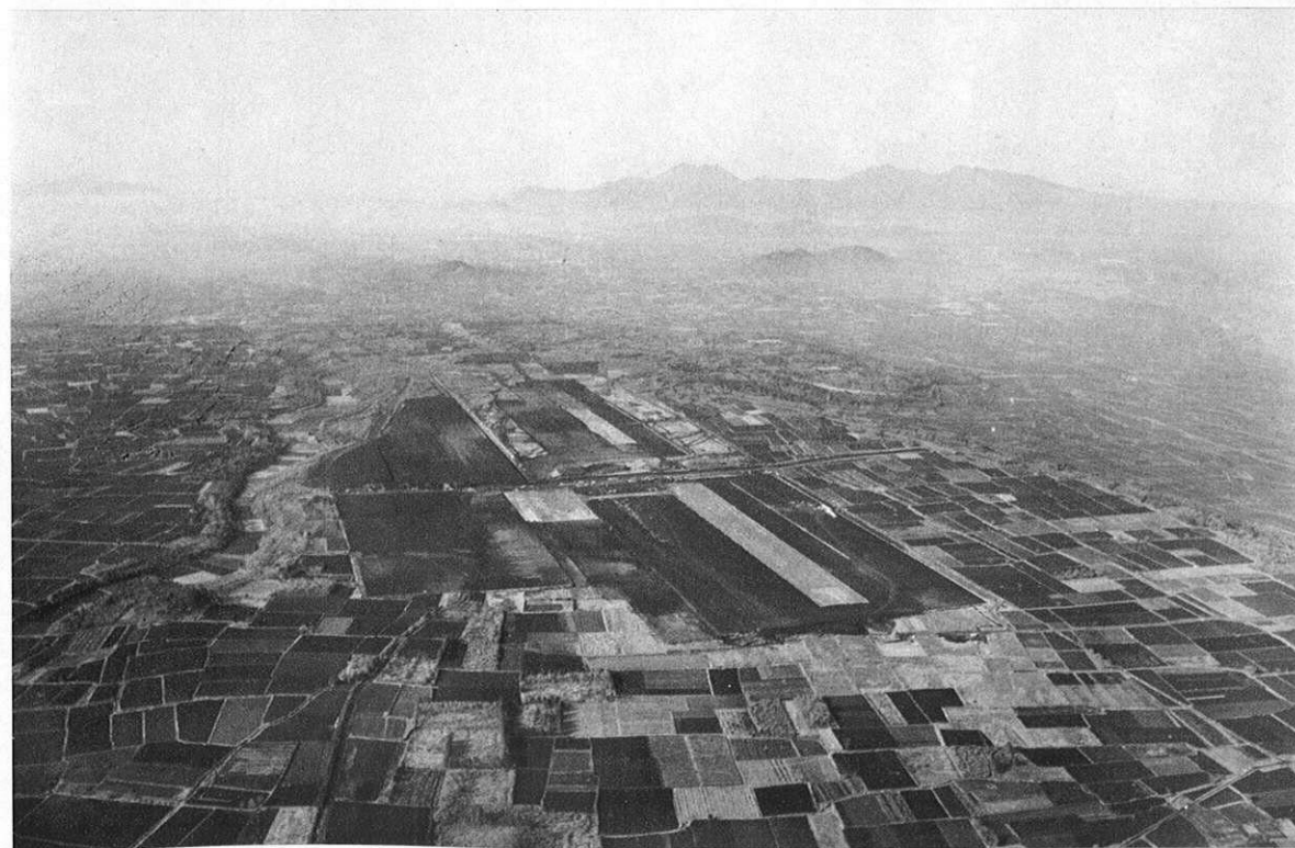
▲2000メートルの滑走路が形をあらわした。新空港は、この秋の開港をひかえて作業も急ピッチに…。
