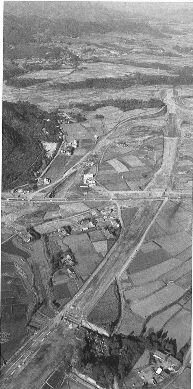
▲九州縦貫道植木インター付近の建設状況。中央を横切るのは国道3号線。スケールの大きさがわかる。
