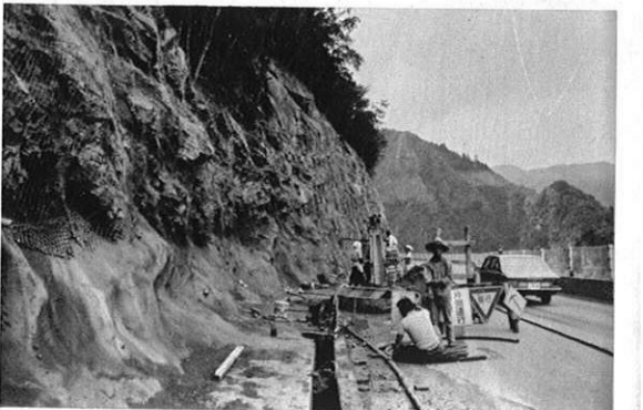
▲球磨川沿岸道路で…崖くずれ防止の作業現場に出あった。道路維持管理もおこたらない。
