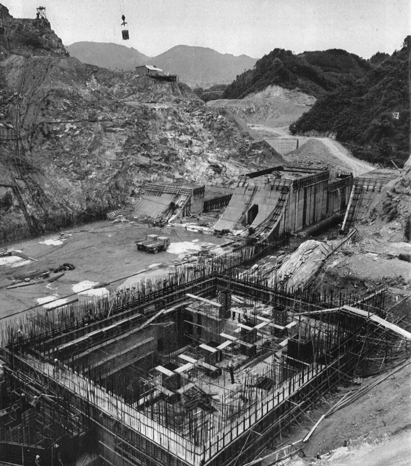
緑川ダム工事現場。手前は県営第一発電所。
