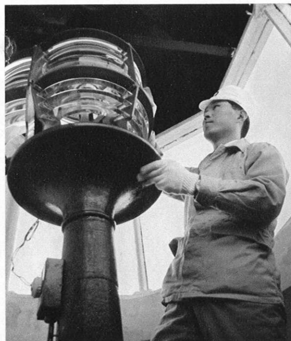
上・月に1回、航路標識事務所の職員が投光器の手入れにやってくる。
