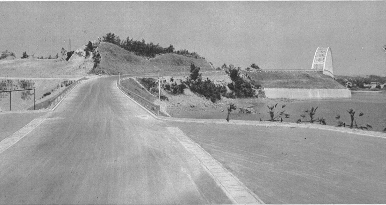
上・大矢野橋のもと。ゆったりしたスペースをもつ駐車場も整備されている。
