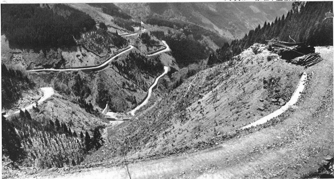
下・五木林道の開発も着々と進んでいる。 (写真は五家荘下屋敷線)
