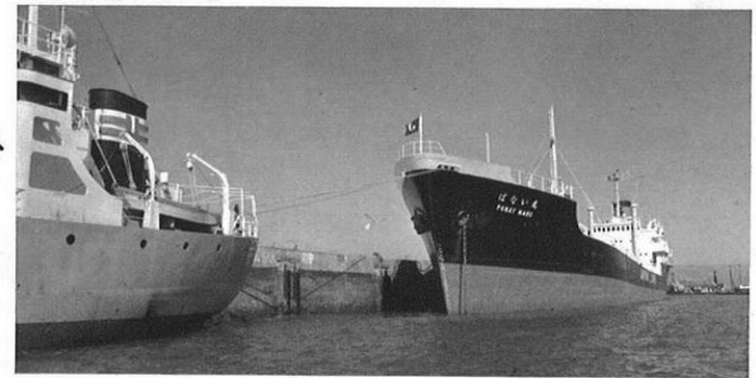
改修された八代港
