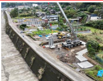
藤本・大門地区工事進捗状況10月末時点 【八代市藤本・大門地区】
