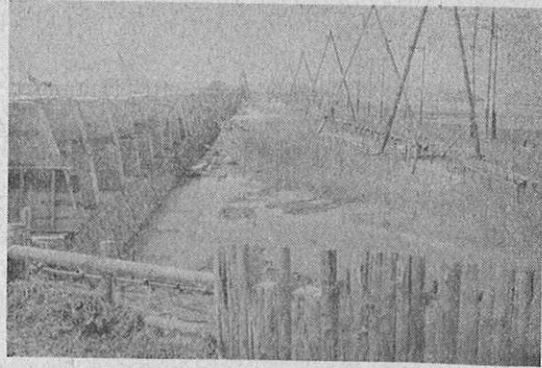
外港には臨港道路も建設中
