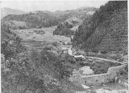
上が地表水の水路で下の穴が地下水の排出口 左前方の白い傾斜地「地すべり」区域
