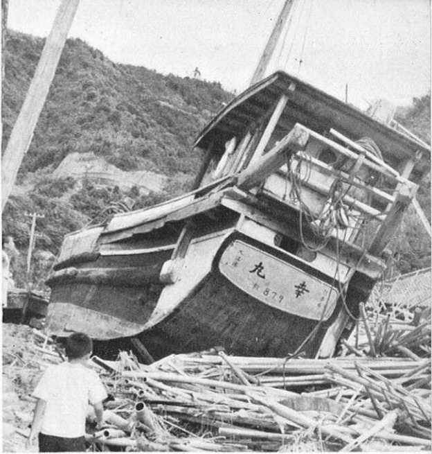
機帆船も道路に打上げられた (天草郡天草町)
