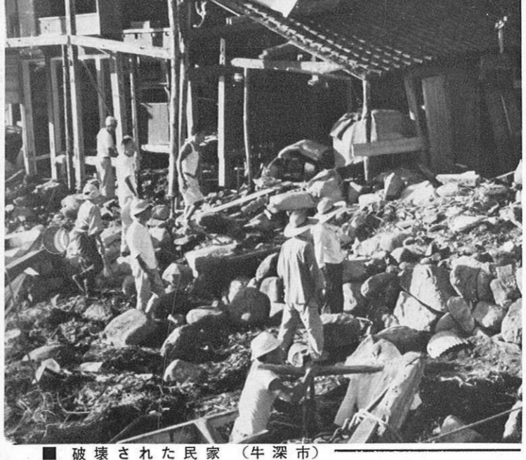
破壊された民家 (牛深市)
