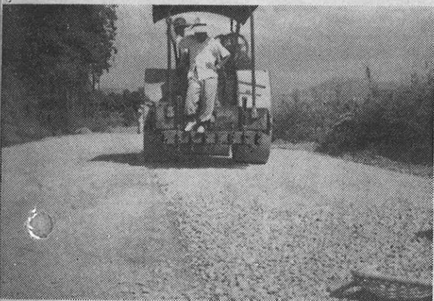
ロードローラーで道路の基礎固めが行われる……★
