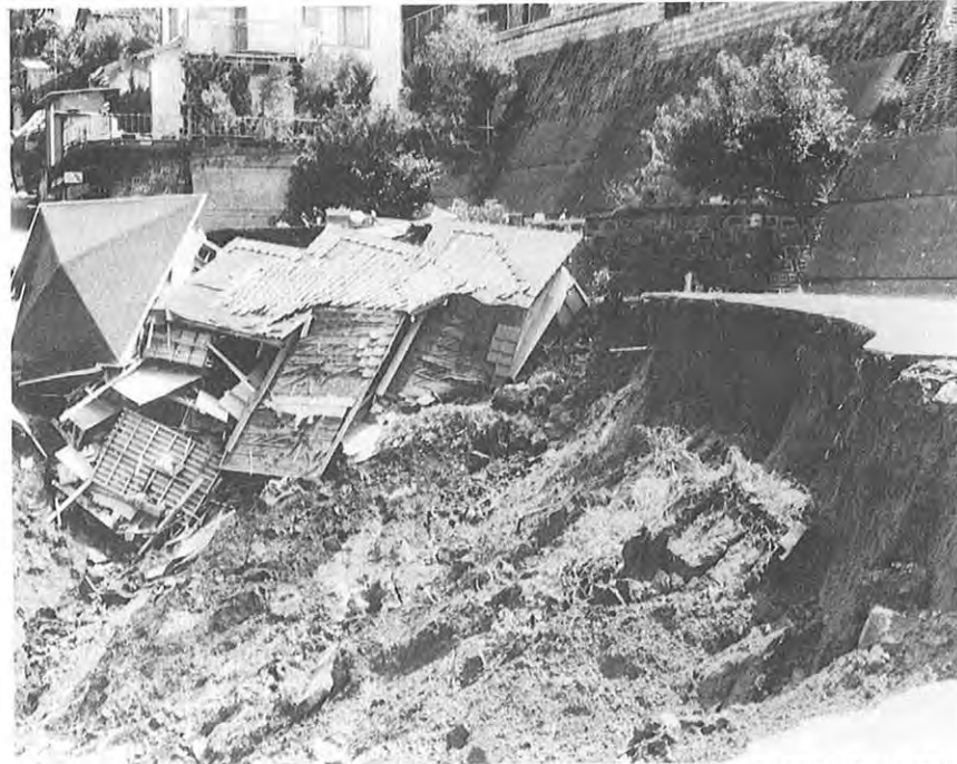
四人が生埋めとなったがけくずれ現場(熊本市池田町)
