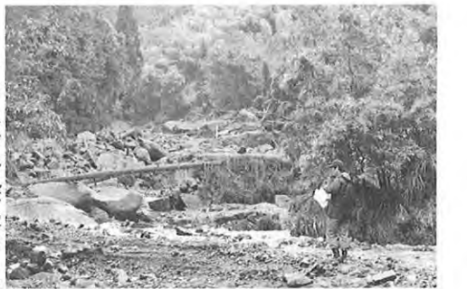
山くずれで地肌が露出した悲惨な現場(水上村)
