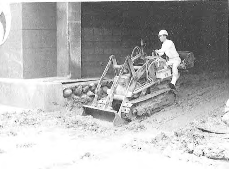
河川のはん濫で流入した汚泥の排出作業 (坂本村)
