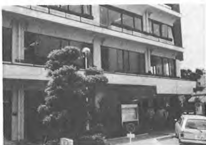
▲ 情報センターが設置された住宅供給公社ビル
