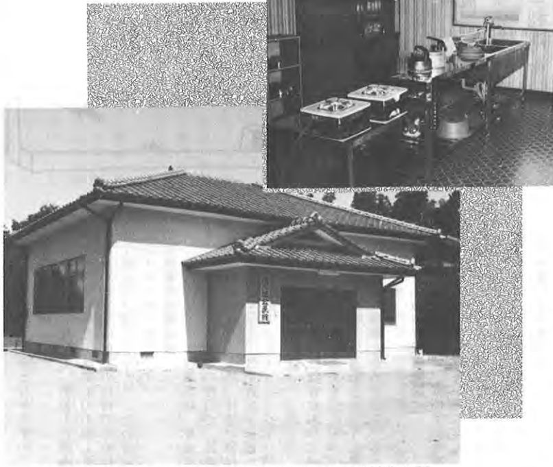
地域の連帯感を生み出す拠点施設の役割をもつ地区集会所
