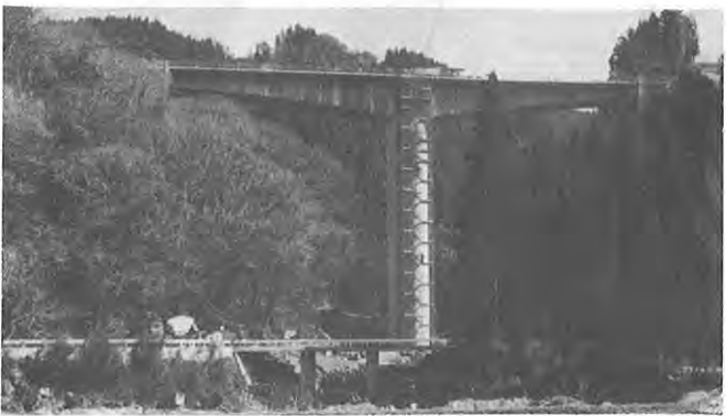
建設中の下城橋（小国町）
