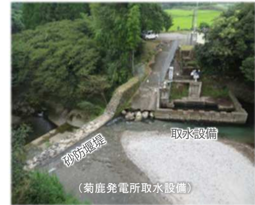
【 砂防堰堤の活用例 】
