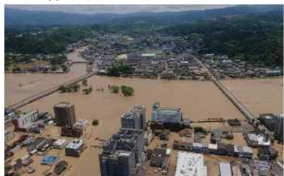
人吉市での被害の様子
