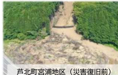
芦北町宮浦地区（災害復旧前）
