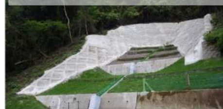
緊急治山事業：人吉市木地屋町（完了後）
