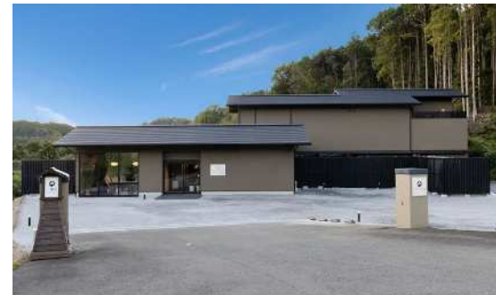
「一富士旅館」(人吉市)の復旧状況
