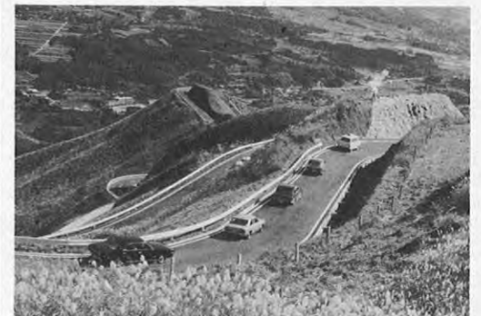
11.9 - 県道熊本・高森線が完成し、俵山峠で開通式が行われた。着工以来23年ぶりに完成したもので、これにより阿蘇南郷谷の地域開発が期待されている。
