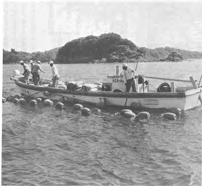
▲水俣湾たい積汚泥処理事業のための仕切網設置作業
