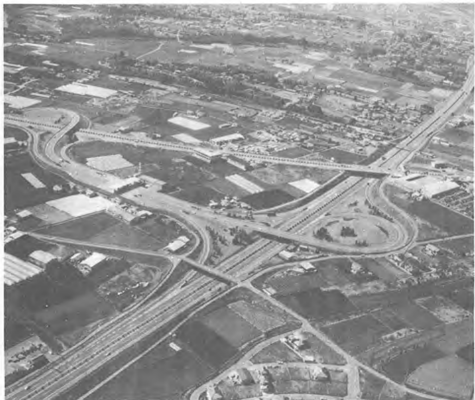
▲整備が進む九州縦貫自動車道（熊本I.C.）
