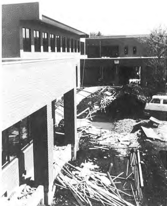
完成近い白水村コミュニティセンター
