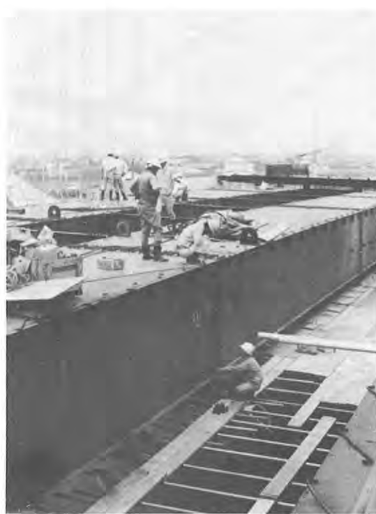
▲九州縦貫自動車道建設工事（八代市）
