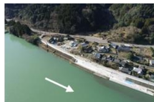
上今泉地区工事進捗状況 3月末時点 【八代市上今泉地区】
