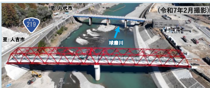
架設完了状況
