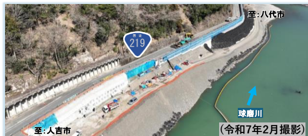
坂本地区の工事状況
