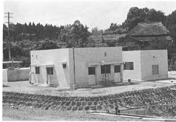
▲松橋町上水道
