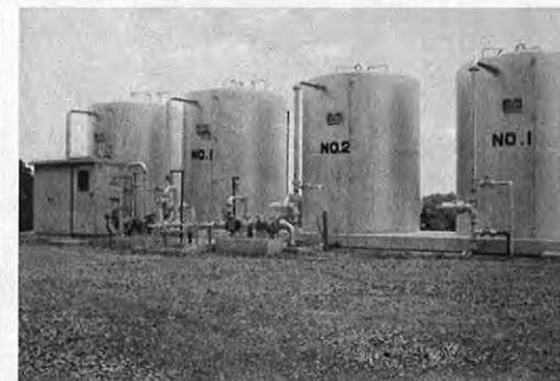
6.1—熊本・福岡両県と大牟田市が共同で進めている、有明工業用水道事業の取水工事が完成しました。(写真は玉名市石貫浄水場)
