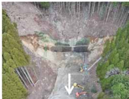
樅木川第3砂防堰堤工事の施工状況
