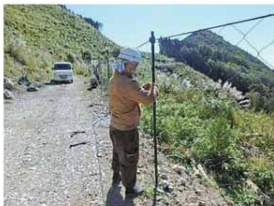
シカ防護柵の設置状況
