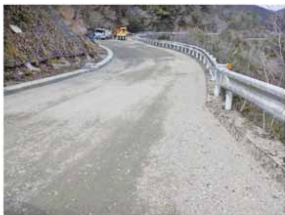
付替村道逆瀬川地区の整備状況
