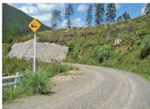
林道開設状況（砂利道）
