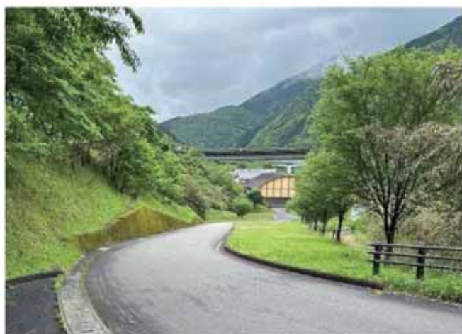
村道中学校線（着工前）
