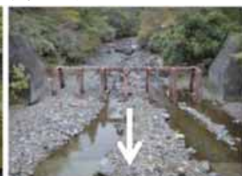
流木撤去後(R6年11月時点)
