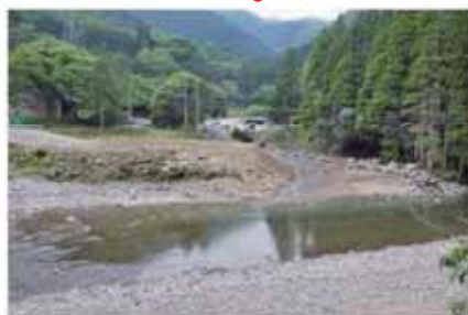
堆積土砂撤去後
