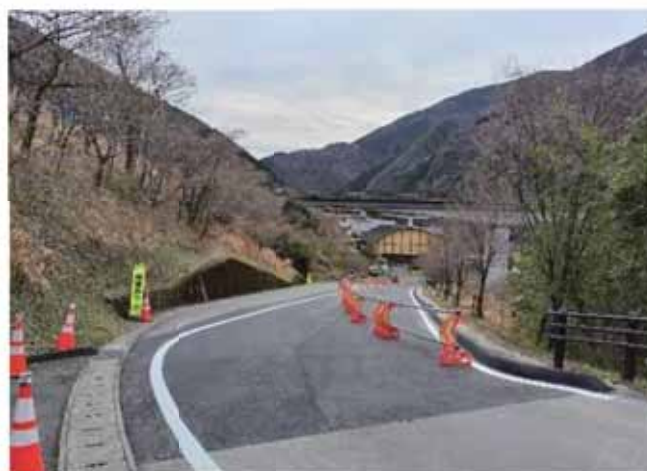
村道中学校線（舗装完了）
