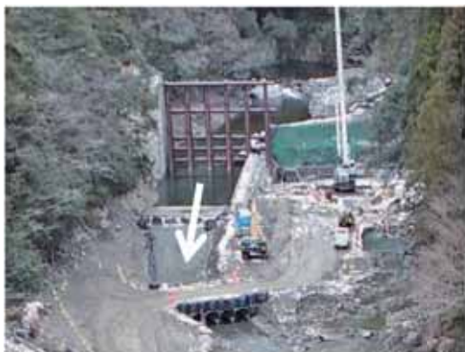
小川第2砂防堰堤工事の施工状況
