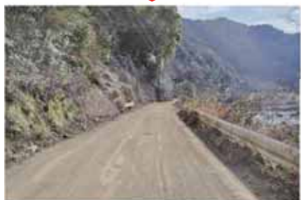
堆積土砂撤去後
