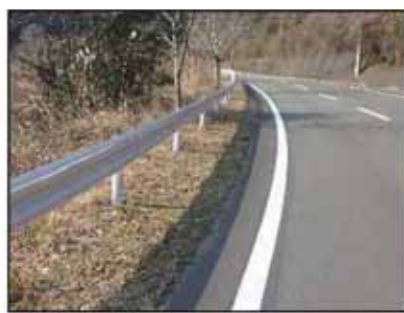
ガードレールの更新
