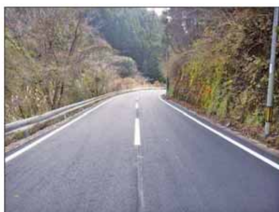
舗装補修工事の実施状況（五木村）
