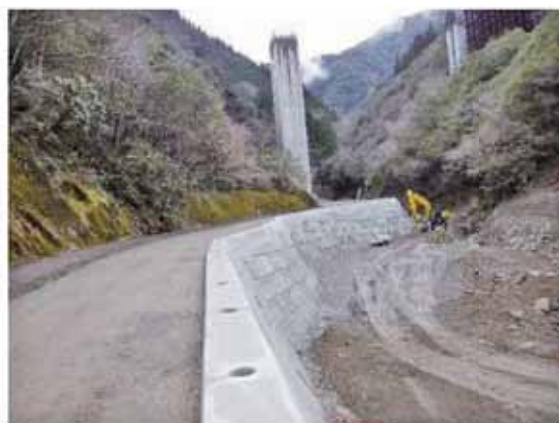
工事用道路の復旧状況
