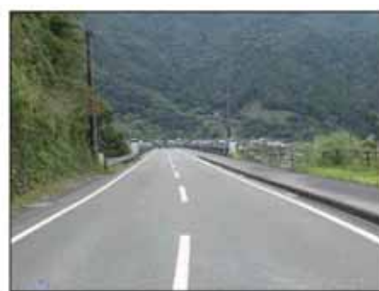
薄くなった区画線の引き直し
