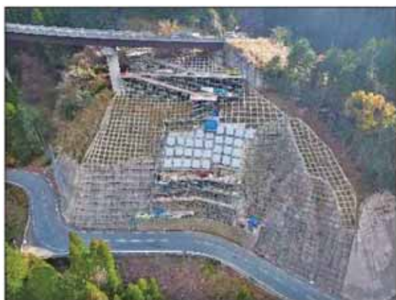
斜面对策工事の実施状況（河俣工区）
