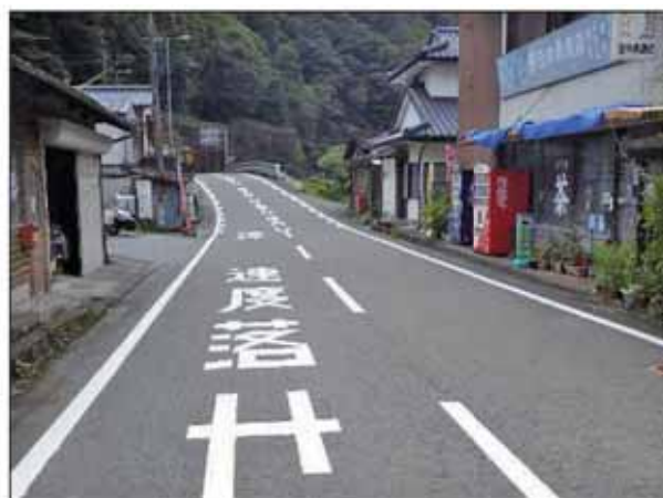
区画線工事の実施状況
