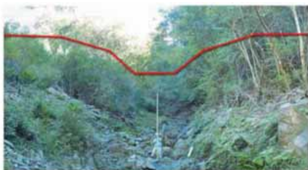
上荒地地区（荒廃状況）
