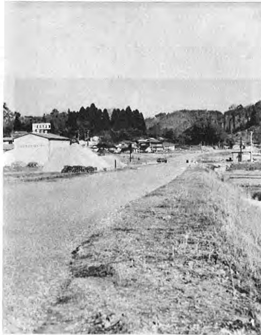
▲産業経済の大動脈国道218号の改良工事
