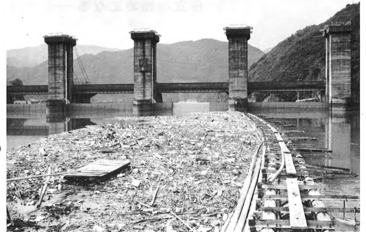
▲荒瀬ダムの流木
