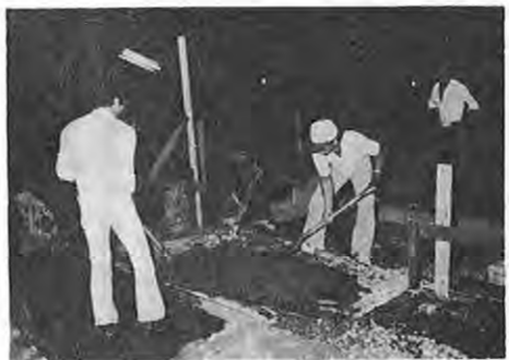
「青年の家」夜間建設作業
