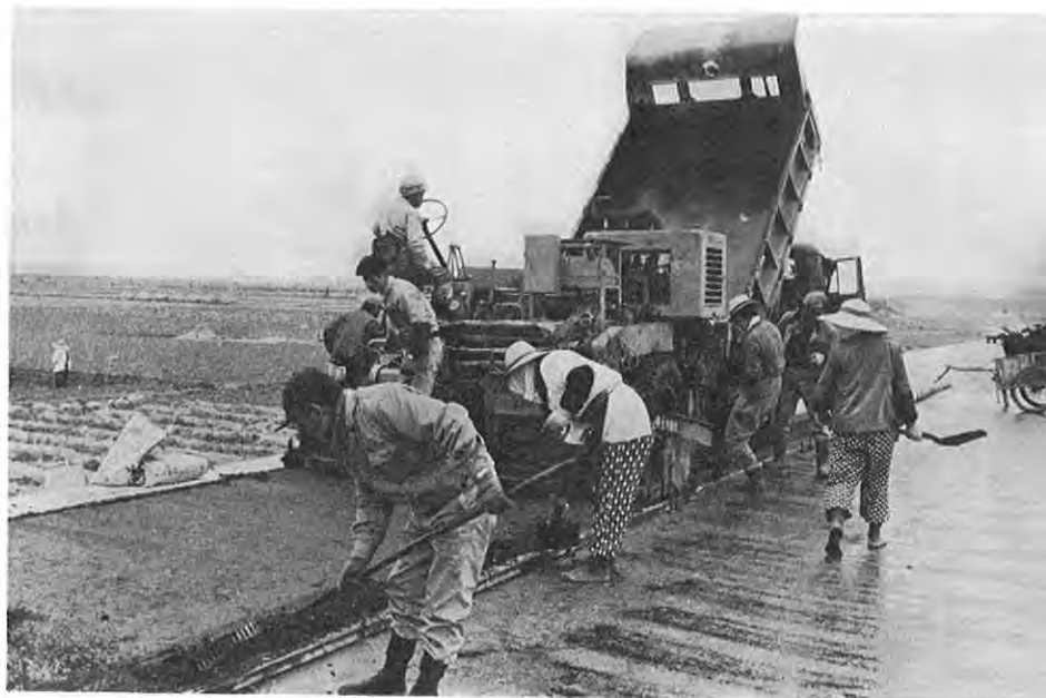
快適な環境にするための農免道も舗装
