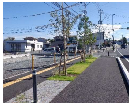
（都）益城中央線 植栽状況
