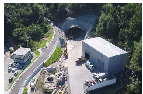
道路改築事業：国道266号（大矢野道路）
