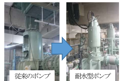
災害復旧と併せて、下水処理場地下のポンプを耐水化（人吉市）
