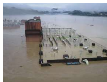
浸水した下水処理場（人吉市）
