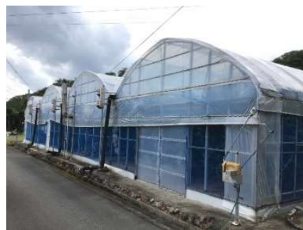
不知火類の加温ハウス
