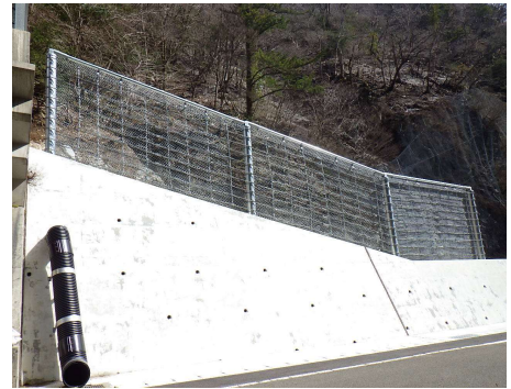
道路防災事業：国道 445 号（八代市）
