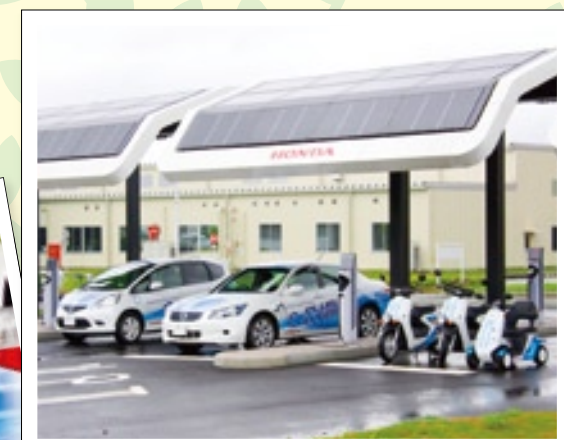
現在3カ所あるソーラー充電ステーションもこれから増設予定です
