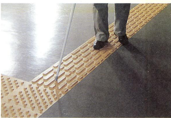
改良事業で敷設した誘導ブロック(健康センター)
