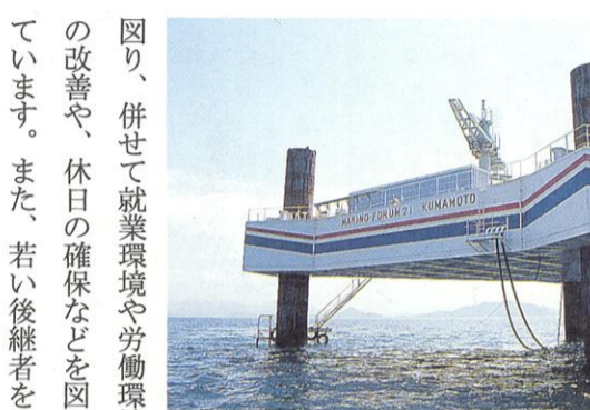
自動給餌システムなどを備えた沖合養殖パイロットファーム(八代海)
